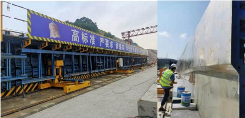
图 11-图 13 T 梁自动化移模
