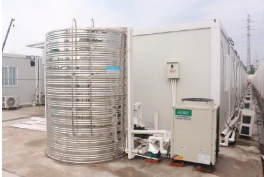
图 23 空气能热水器
