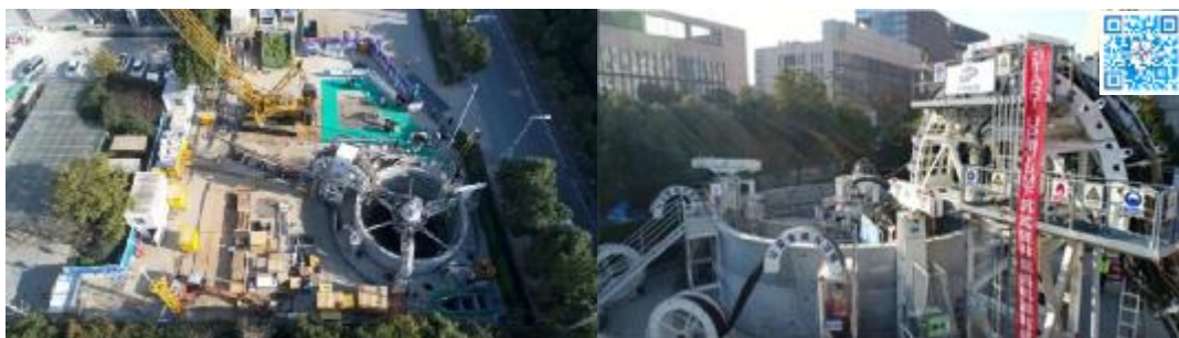
图 28 VSM沉井式地下停车场开工
