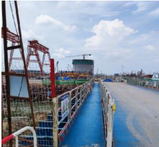
图 16-图 17 钢栈桥
