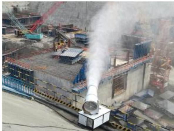
图 22 雾炮机工作示意图
