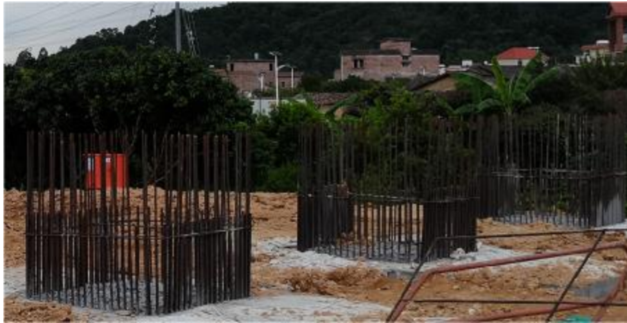
图 27 方墩预埋主筋未装钢筋保护帽
