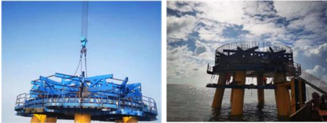
图 18-图 19 钢套箱模板
