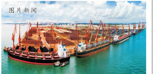
图片新闻 本报讯 7月2日,公司承建的北海铁山港区1-4号泊位工程(二期)通过竣工验收,建设规模为2个10万吨级通用泊位,建设内容包括码头水工、码头前沿停泊地、回旋水域、堆场、道路等生产及配套设施。(马俊孝)
