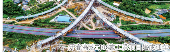
开春高速TJ08施工段项目建成通车
