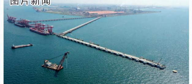
本报讯 8月23日，防城港企沙港区赤沙作业区1号泊位胸墙浇筑完成，标志着工程上部主体结构全部完成。该工程是国家“十四五”规划推进西部陆海新通道高质量建设的重点项目，拟建设1个20万吨级散货泊位（码头水工结构按30万吨级预留），设计年吞吐量950万吨，设计年通过能力980万吨。项目建成后对推进北钦防一体化发展、推动北部湾国际门户港和国际枢纽海港高质量建设发展、实现西部陆海新通道建设规划具有重要意义。
