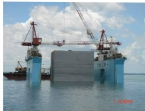
防城港号装载长 14.2m 宽 15.36m 高 115.8m 重 1600t 沉箱定位出坞
