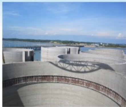
广西钦州港3-8#泊位工程圆筒
