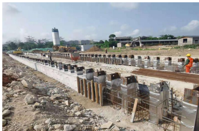
图 24 H 型钢圈梁施工
