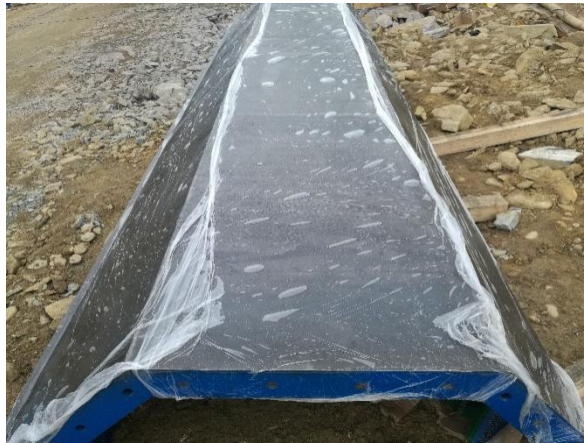
图 28 塑料薄膜覆盖保护
