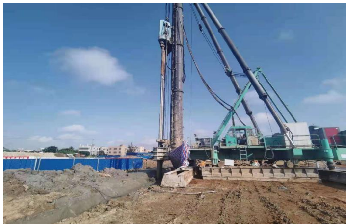
图 23 三轴搅拌桩施工
