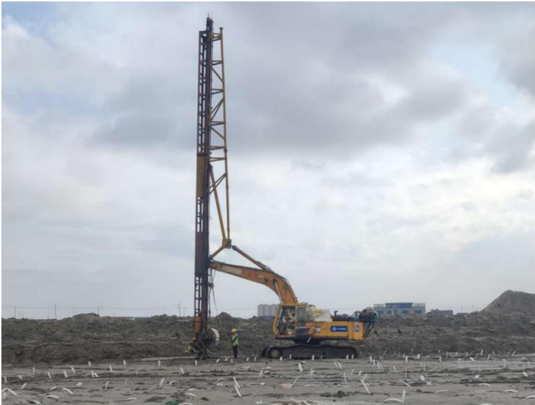
图 17 插板机打设排水板作业
