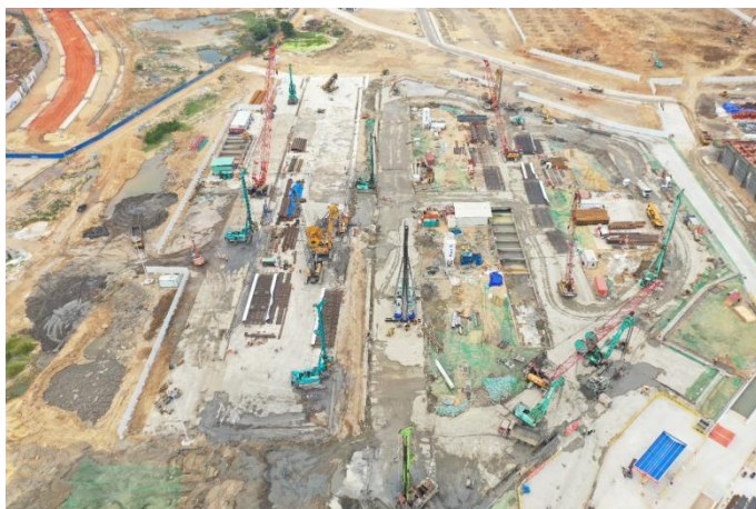
图 22 地铁站地连墙施工航拍
