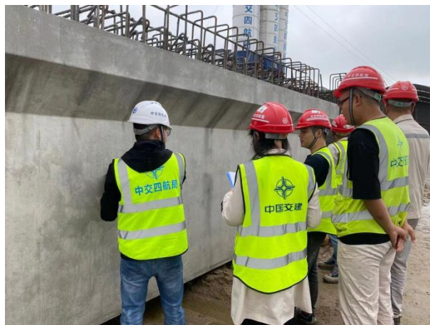
图 2 南通项目技术管理检查
