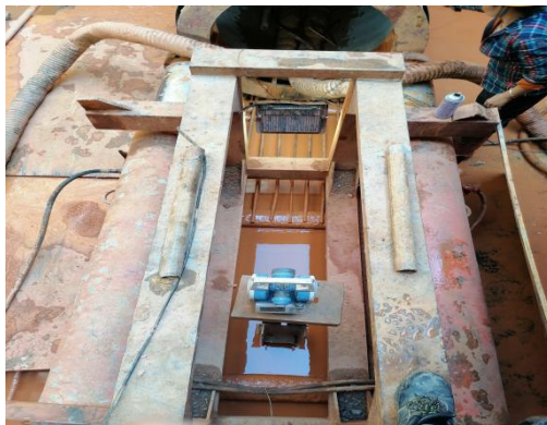
图 20 顶管激光发射器
