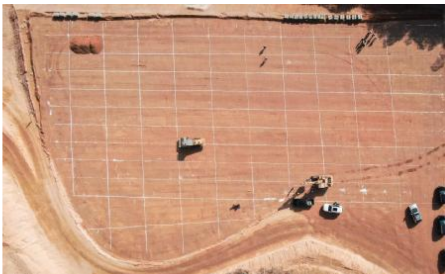
图 12 路基填筑画网格线控制
