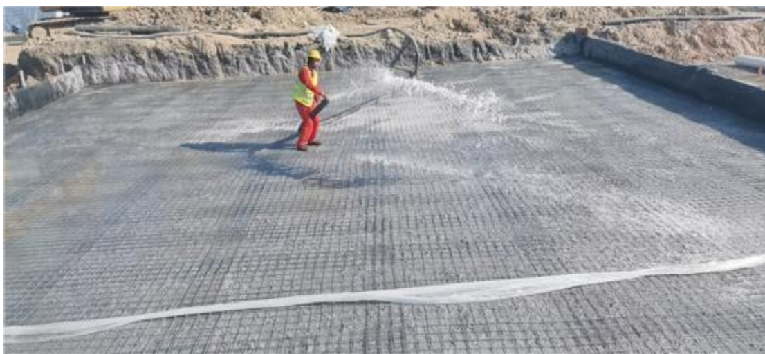
图10 气泡轻质土洒水养护
