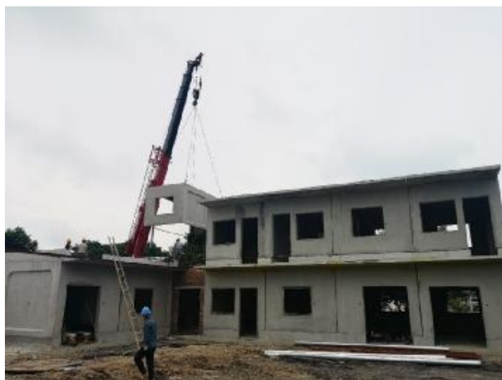
图 14 预制房屋吊装拼装
