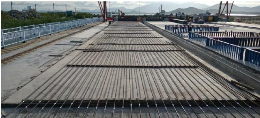
图8 预应力面板钢筋
