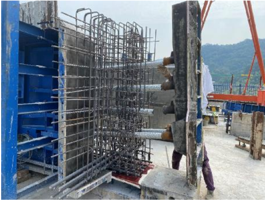
图 22 T 梁端头模板打磨不干净。
