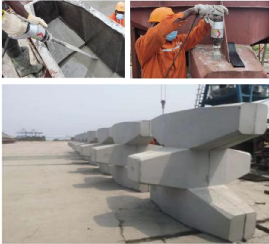
图 17-图 19 混凝土引气铲的应用
