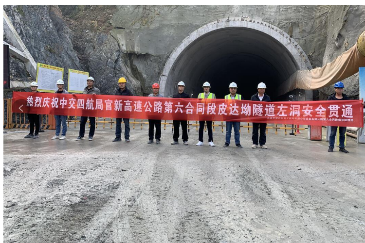
图9 官新高速项目皮达坳隧道左洞顺利贯通
