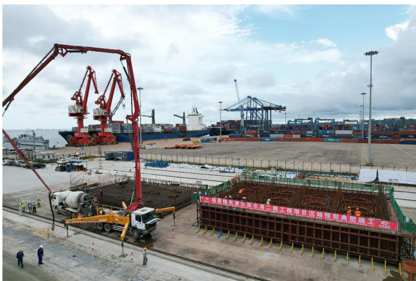
图 11 喀麦隆项目部沉箱预制典型施工
