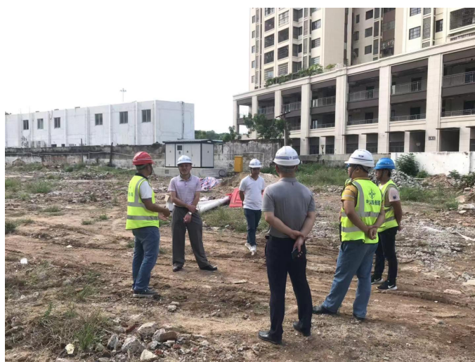
图 26 海口棚改项目技术检查
