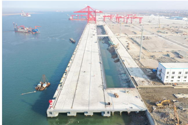
图7 南通港吕四作业区西港池 8#-11#码头
