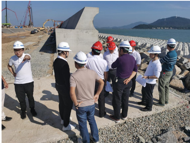
图 28 参与阳江 LNG 项目现场考察
