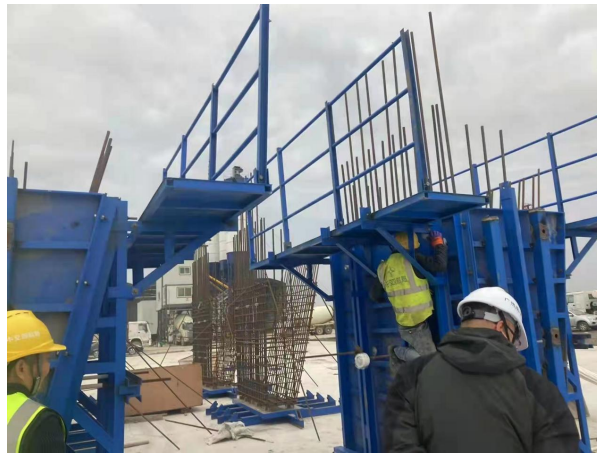
图 16 靠船构件桁架式模板
