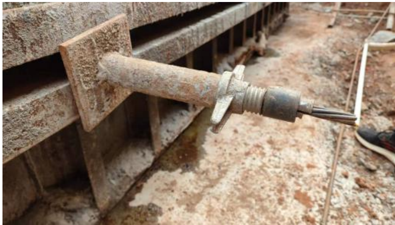
图 18 钢绞线拉杆现场安装图
