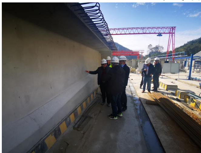
图 30 官新项目现场技术检查
