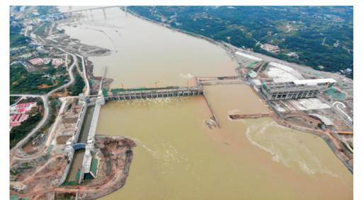
**本报讯** 10月9日，岷江犍为航电枢纽工程三期围堰成功截流。该工程是以航运为主，结合发电，兼顾供水、灌溉的水资源综合利用工程，项目总投资104.24亿元。三期围堰作为工程最重要的分项部分，对实现岷江犍为航电枢纽工程年底“通航、蓄水、发电”三大目标具有极其重要的意义。
