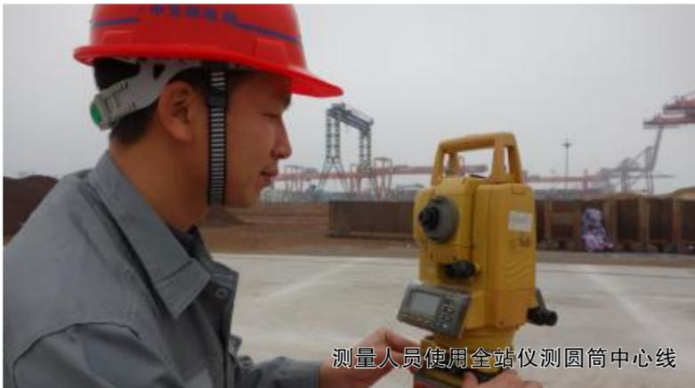
测量人员使用全站仪测圆筒中心线
